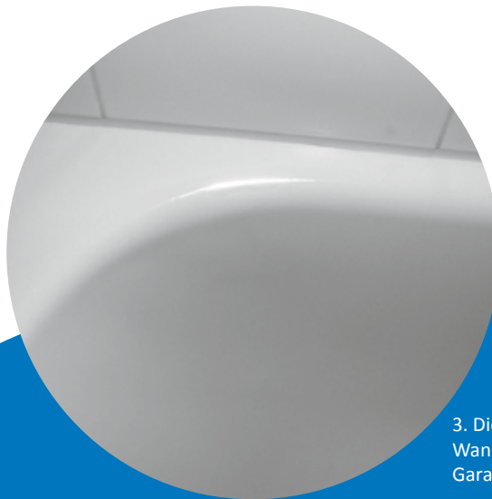
2. Die Reparatur wird farblich an die Bade-, Duschwanne oder an das Lavabo angepasst.
